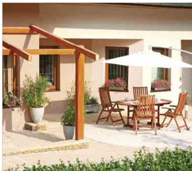
Stav po rekonštrukcii
