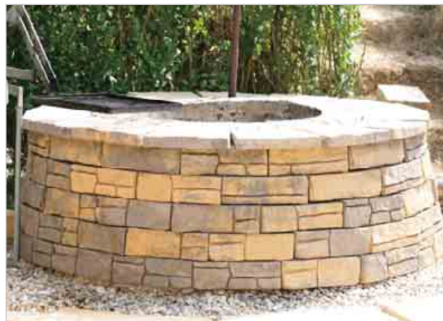
Stav po rekonštrukcii
