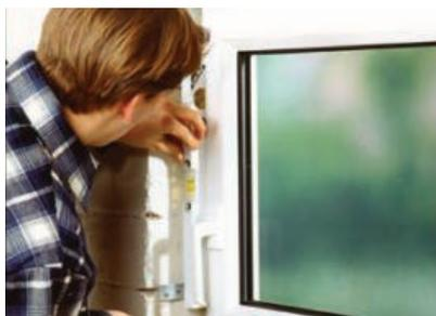
Zkontrolujte pozici okna v otvoru. Pomocí příklepové vrtačky vyvrtejte otvory potřebných rozměrů pro hmoždinky a osadte hmoždinky.
