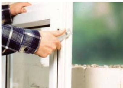
V každém rohu okna upevněte kotvu šroubem. Umístěte okno do otvoru ve zdi, srovnajte pomocí vodováhy a fixujte do rohů pomocí klínů (15 - 20 cm od rohů rámu).
