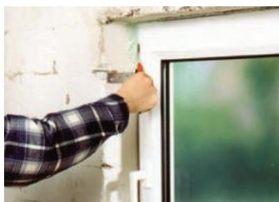
Po zatuhnutí přebytečnou montážní pěnu odříznete ostrým nožem.
