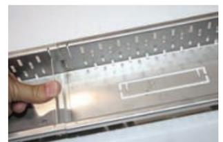
4. Fixační spojku zatlačte do zářezů, čímž dojde k pevnému spojení obou žlabů
