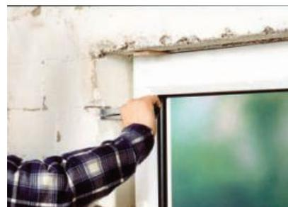
Vruty 5x45 mm přichytíte kotvy okna do zdi. Poté proveďte kontrolu správné funkce okna (otevření / uzavření).
