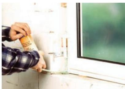
Mezeru mezi rámem a otvorem v rozích vyplníme montážní pěnou. Při aplikaci pěny musí být okno uzavřené. Pokud je nutné provést vyplnění po celém obvodu, rozepřete rám tak, aby rozpínající pěna rám neprohnula.
