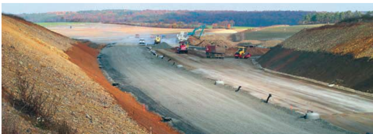
Novostavba A 71 – instalace systému Aqua-pipe
