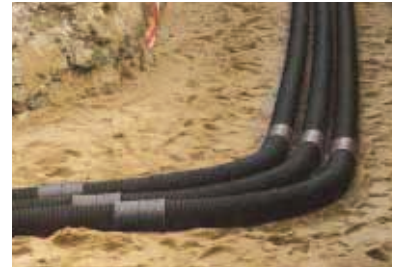
Oblouky pod úhlem 45° a 90° umožňují jednoduchou změnu směru. Větší poloměry jsou možné díky ohebnosti trubky.
