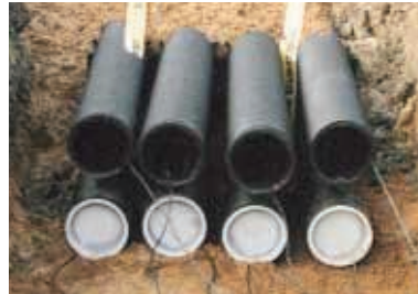
Distanční držáky udávající směr urychlují pokládku a zvyšují její bezpečnost.
