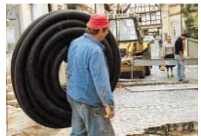
Při pokládce do zatáček není nutné používat oblouky. Snadná pokládka také na delší vzdálenost bez přerušení.
