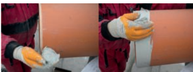
5. Nanesenie klzného prostriedku na očistené hrdlo potrubia
