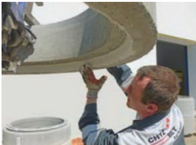
3. Osadenie jednotlivých dielov na seba
