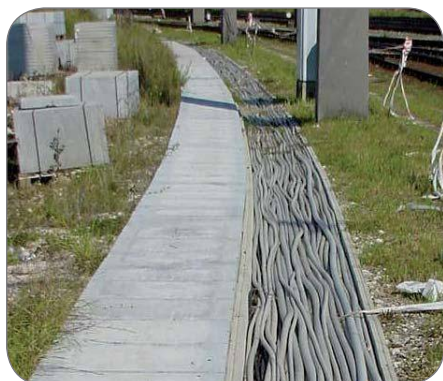
Na základe svojej stavebnej výšky je možné do tohto žľabu uložiť množstvo káblových vedení
