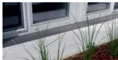
BG-FA s protišmykovým mriežkovým roštom
