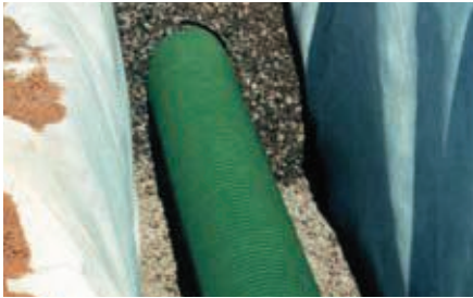
Vsakovanie pomocou potrubného vedenia Sicku-pipe:
