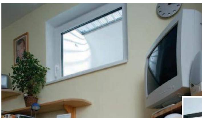
Pivničné svetlíky (anglické dvorce) a plastové okná)
